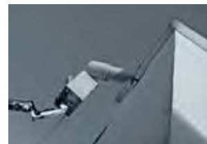
Torre de Váia (execução), José Pedro Santos, São Paulo de Merelim, 2020.
