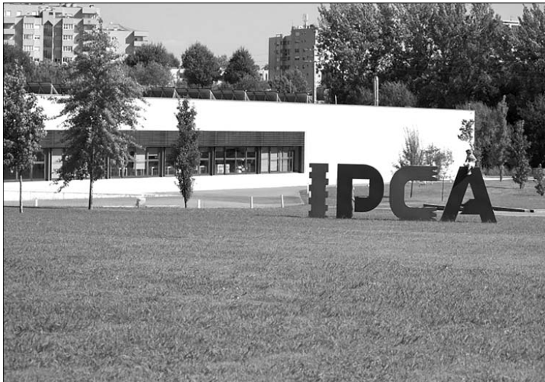
Novo projeto do IPCA prevê novas construções numa área de 29 mil metros quadrados
