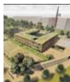
A escola de hotelaria e turismo do IPCA vai repartir-se pela Casa do Costeado e por um novo edifício de madeira
